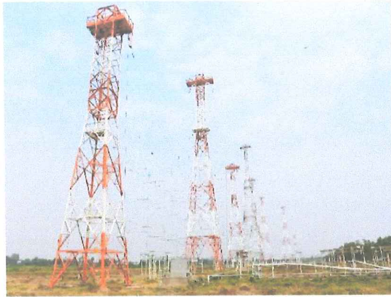
รูปภาพที่ 1 เสายึดโยงสายอากาศตราอักษร Marconi จำนวน 9 ต้น
