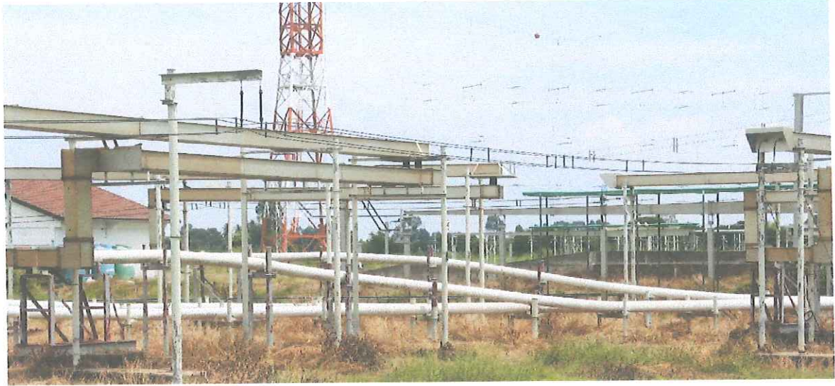
รูปภาพที่ 4 อุปกรณ์สำหรับการเปลี่ยนทิศทางการแพร่กระจาย สำหรับสายอากาศตราอักษร Macroni พร้อมอุปกรณ์ส่วนควบ
